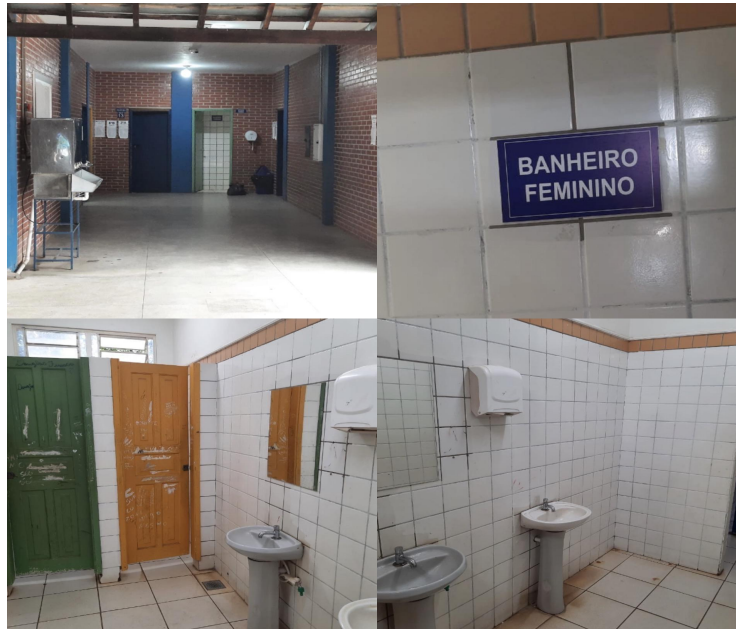
Figura 2: Corredor onde ficam os banheiros e banheiro feminino, com vigilância remota no corredor - Escola Edwards Corrêa e Souza – Três Lagoas/MS
