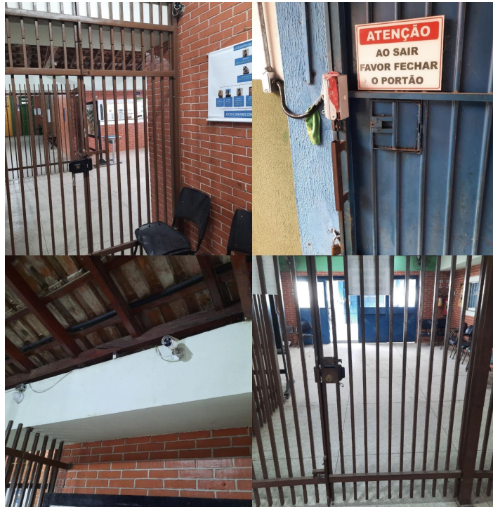
Figura 1: Sistema de monitoramento com câmeras, portões de ferro e portões em grade e trava eletrônica, Escola Edwards Corrêa e Souza – Três Lagoas/MS Fonte: o autor.
