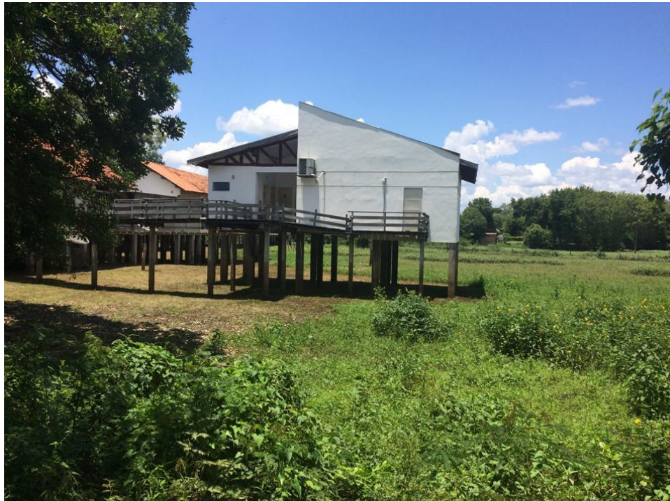
Foto 3. Construção elevada na BEP – UFMS, comum no ambiente pantaneiro. Crédito: Autor 2019.
